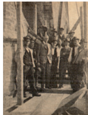
296 Lübeck, Marienkirche, Gruppe der Zimmerleute mit dem Architekten und dem Zimmermeister auf den Gerüsten an den Marientürmen beim Abschluss der Arbeiten (Aufn. Okt. 1932)
