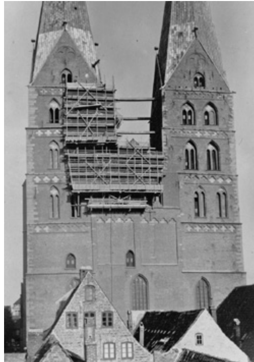
293 Bauzustand der Lübecker Marienkirche im Jahr 1932 während der ersten Injektionskampagne
