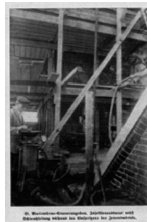
295 Lübeck, Marienkirche, Injektionsapparat nebst Schlauchleitung während des Einspritzens des Zementmörtels
