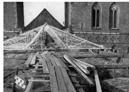
Abb. 11: Notdach des Mittelschiffs (Foto: Nachlass Overhage)
