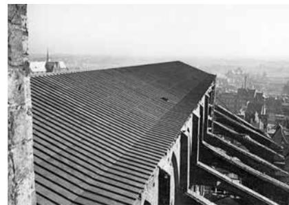
Abb. 10: Notdach des Mittelschiffs (Foto: Nachlass Overhage)
