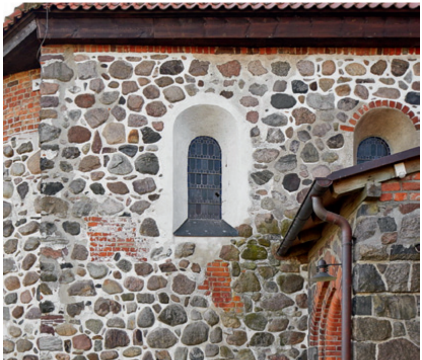
6 Ratekau, Altarhaus der Kirche von Norden nach der Sanierung von 2009, historische Ver fugungen weitgehend durch neue Ver fugung ersetzt (Aufn. 2014)
