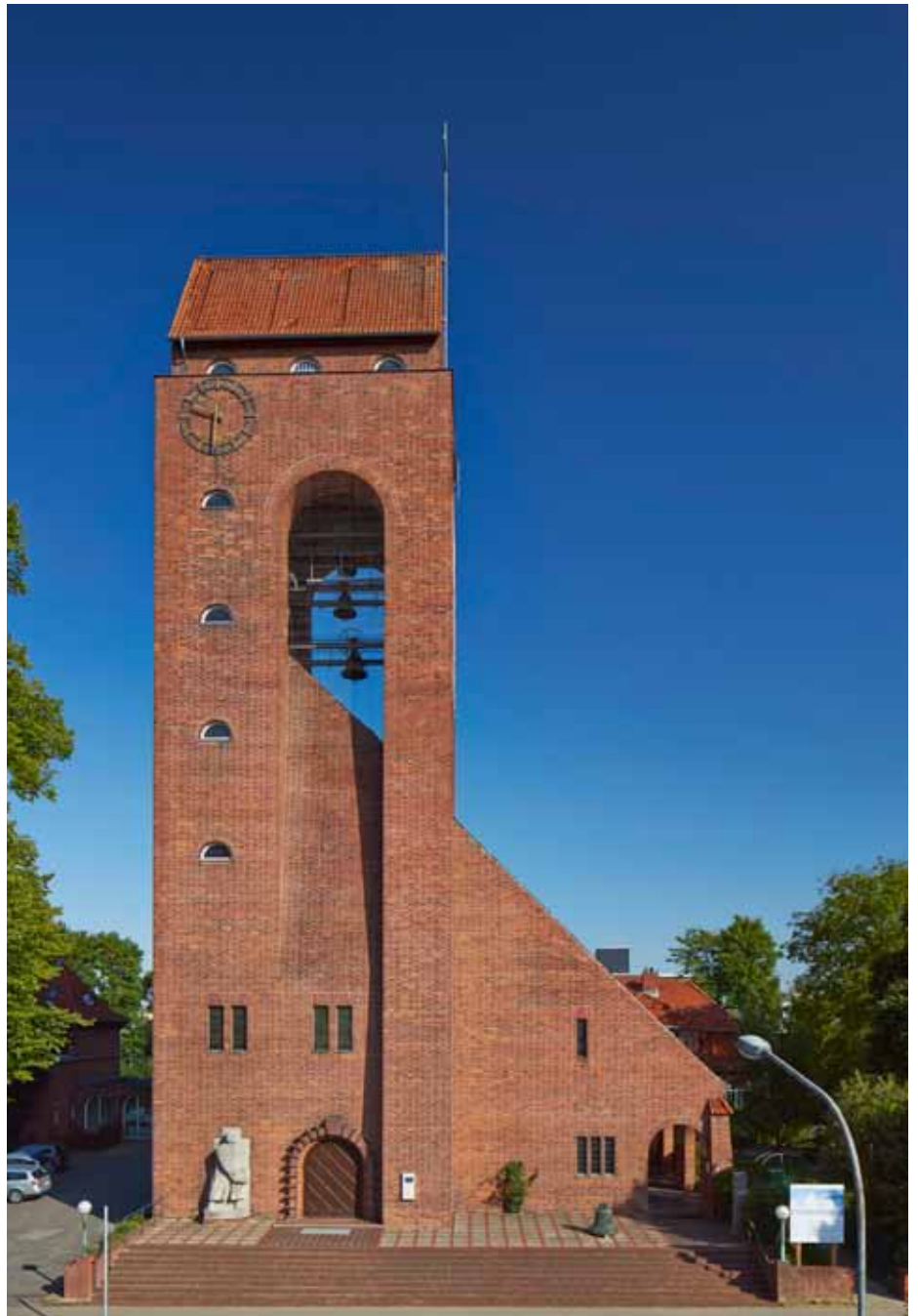
1 Außenansicht der Ev. Lutherkirche in Lübeck, Moislinger Allee 96, erbaut 1936/37 von Willy Glogner und Paul Vermehren
